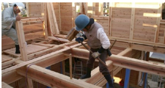
図 4-46 板倉構法の施工のようす 2
